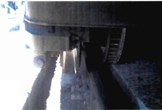
Bogie Motriz M2 Descarrilado
