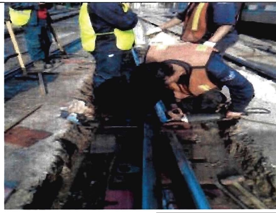
Trabajos de Mantenimiento a pieza de cruzamiento JC #11
