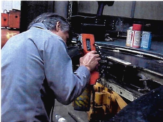
Revisión de fisuras en travesero de articulación de tren por el método de partículas magnéticas.
