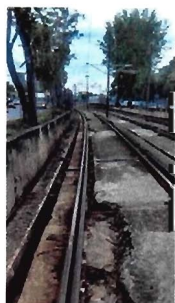
Sobre elevacion de 150 mm en curva de Nezahualpilli
