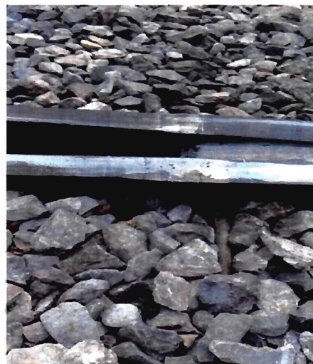
Bisel doble fractura pieza de cruzamiento de juego de cambo numero 5 via 2 fila c pk 1+951
