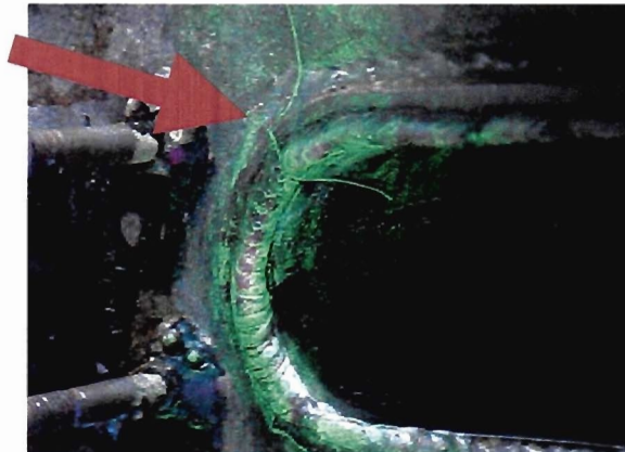
Fisuras detectadas en travesero de articulación por el método de partículas magnéticas
