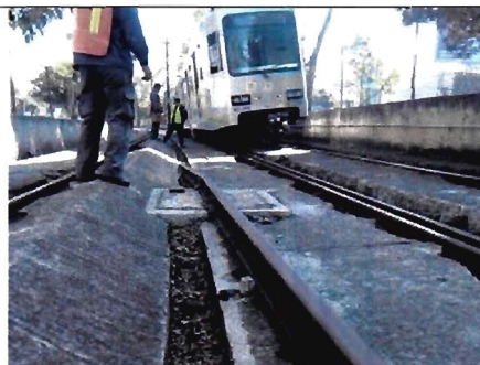
Sobre elevacion de 150 mm en curva de Nezahualpilli
