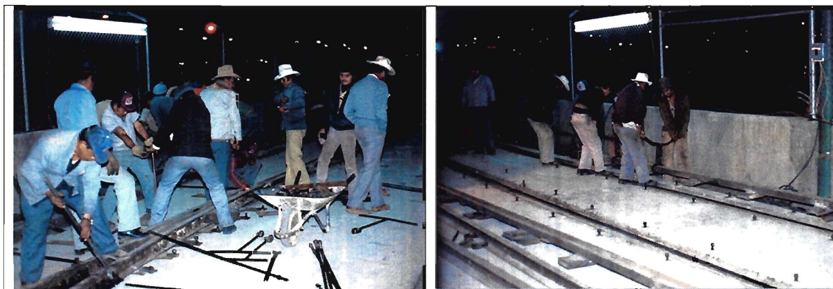
Trabajos de reconstrucción de la vía 1984 - 1986
